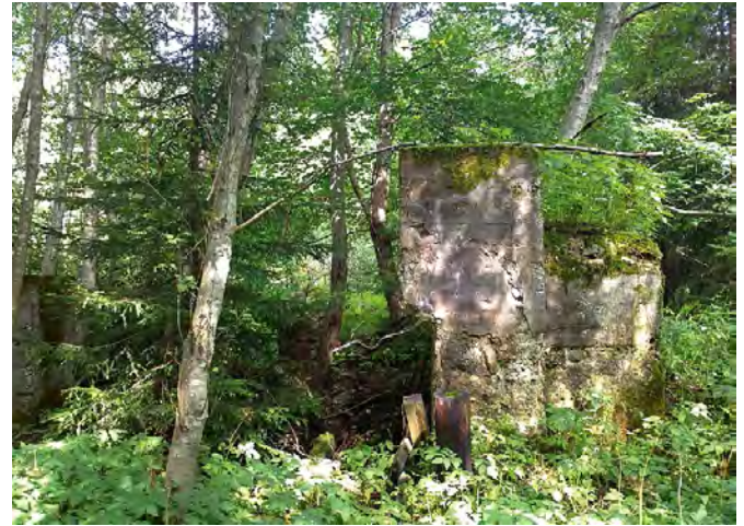
Metsaestakaadist Surju vallas Jaamakülas on alles veel betoonvundament
